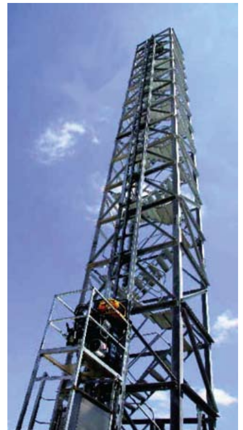
Рис. 1. Тестовая башня компании TESI
