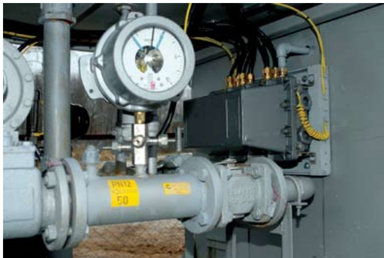
Рис. 6. Размещение комплекса АКТЕЛ в ШРП
